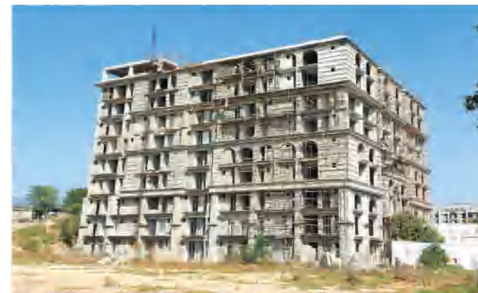
The Arch Actual Image
