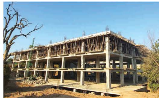
The Arch Actual Image
